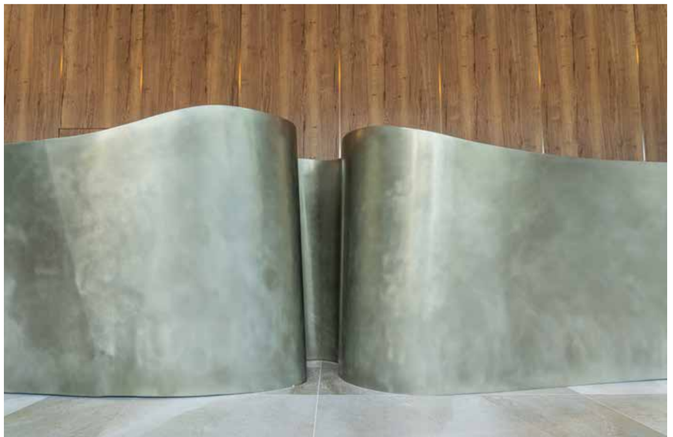
Bancone in acciaio inox spazzolato finitura Champagne Champagne finish on brushed stainless steel counter
